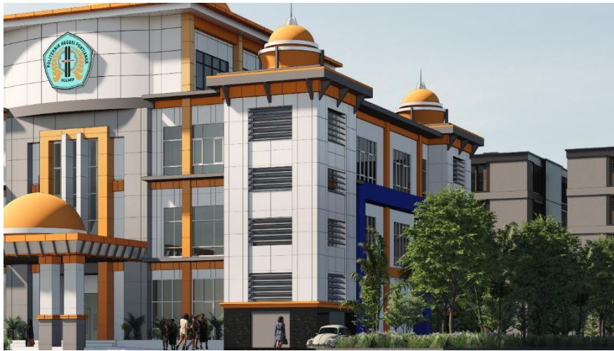
Gambar 20. Perspektif bagian dinding kaca tower bangunan Gedung Direktorat Polnep dengan pengubahsuaian penambahan shading dan dinding ACP
