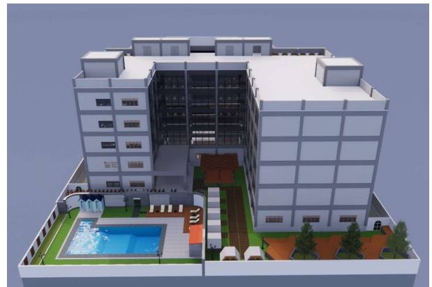
Gambar 10. Tampak belakang bangunan gedung
