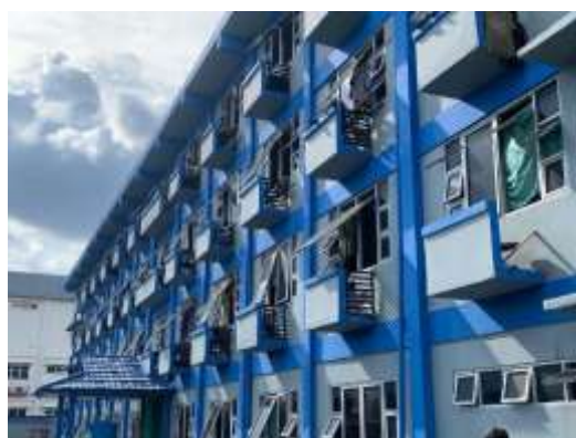
Gambar 2. Bangunan Gedung Rusunawa Polnep
