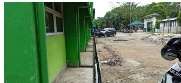
Sumber: Foto Dokumentasi (2021)
