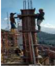
Gambar 17. Dokumentasi Pekerjaan Kolom
