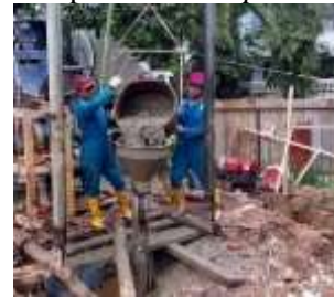
Gambar 16. Pengecoran Bore Pile
