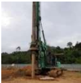
Gambar 15. Pengeboran Pondasi Bore Pile
