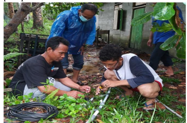
Gambar 4. Pemasangan instalasi pipa dan generator mini.
