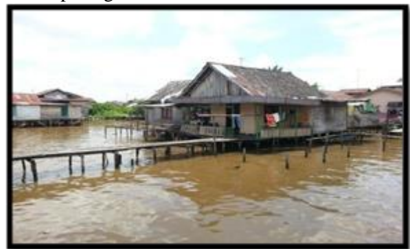
Gambar 3. Kondisi rumah dan jalan
