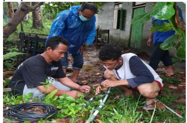
Gambar 4. Pemasangan instalasi pipa dan generator mini.
