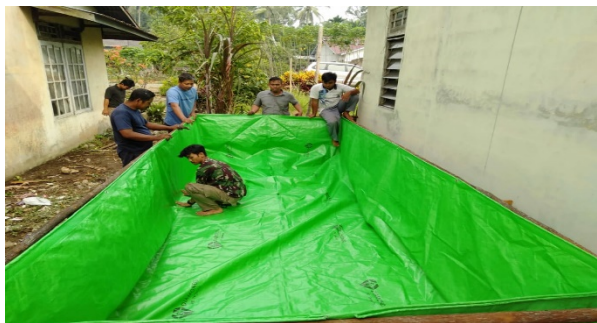
Gambar 1. Pemasangan rangka kolam terpal.
