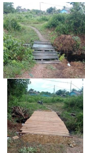
Gambar 6. Dokumentasi Jembatan sebelum dan setelah pembangunan
