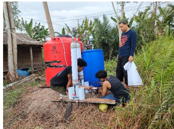
Gambar 6. Pemasangan Instalasi Penjernih Air
