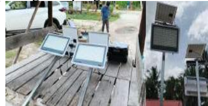
Gambar 7. Pemasangan lampu PLTS
