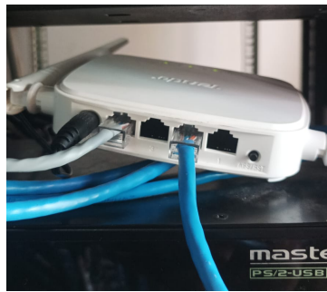
Gambar 2. Proses Instalasi Perangkat penghubung koneksi
